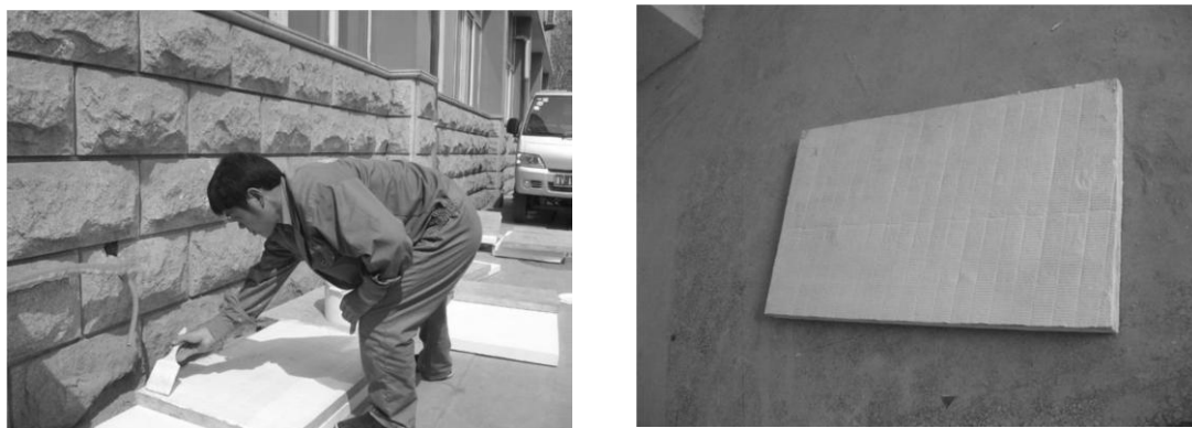
图 4.2 涂刷岩棉板界面砂浆
