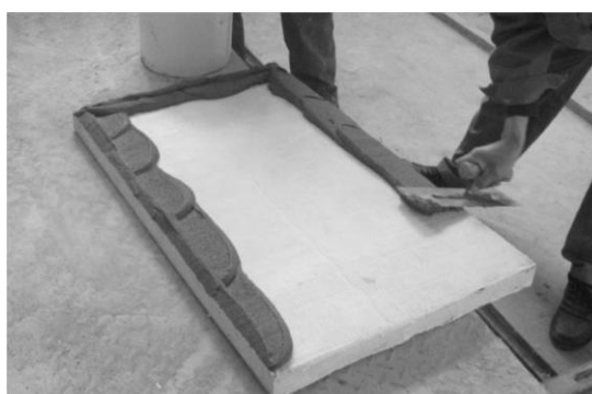
图 4.3 岩棉板粘贴面批抹粘结砂浆
